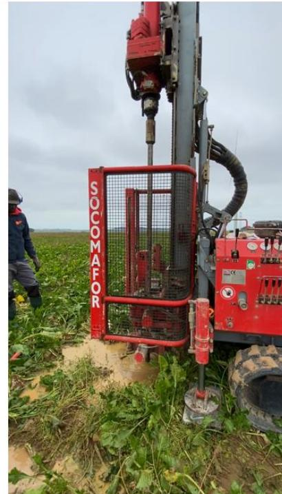
Ces sondages ont été réalisés par la société experte en géotechnique éolienne, ALIOS. Ce chantier a pris fin le 05/11/2025. VALOREM reste dans l'attente du rapport d'ALIOS pour officialiser l'absence de cavités à ces emplacements, et le transmettre au service urbanisme de Criel S/ Mer, afin de lever partiellement l'indice de cavité.
